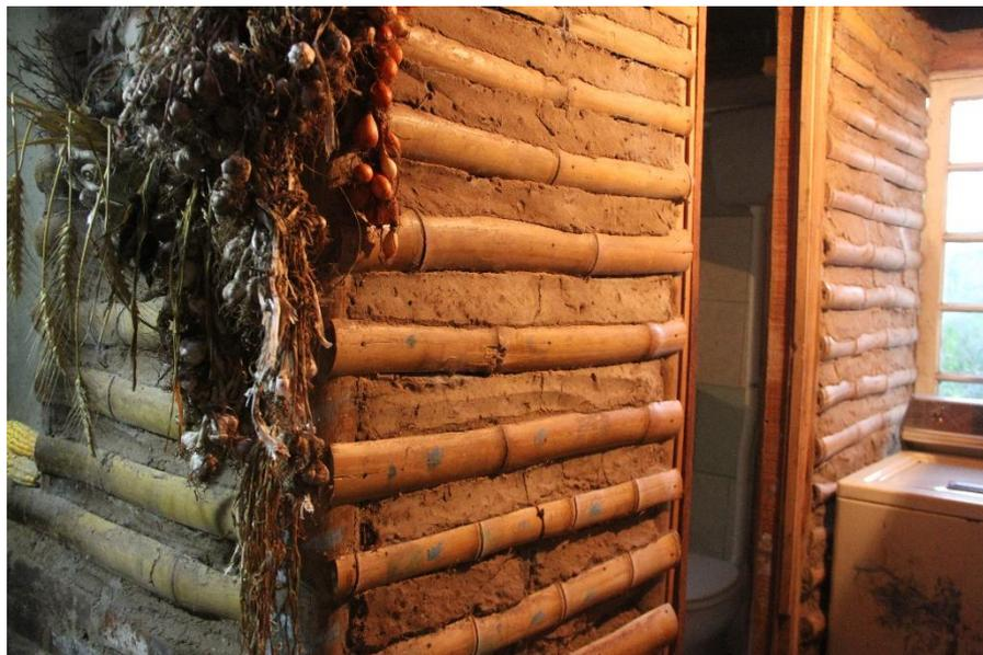
Figura 18: biconstrução utilizando técnica de taipa de mão.
