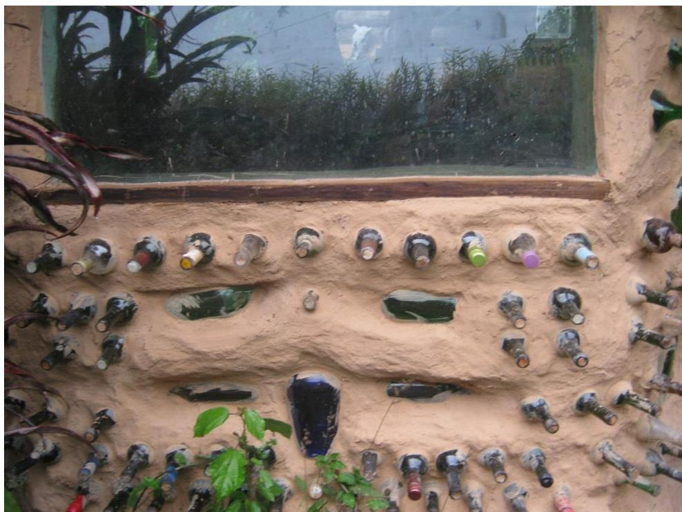
Figura 17: parede construída com solo cimento e garrafas.
